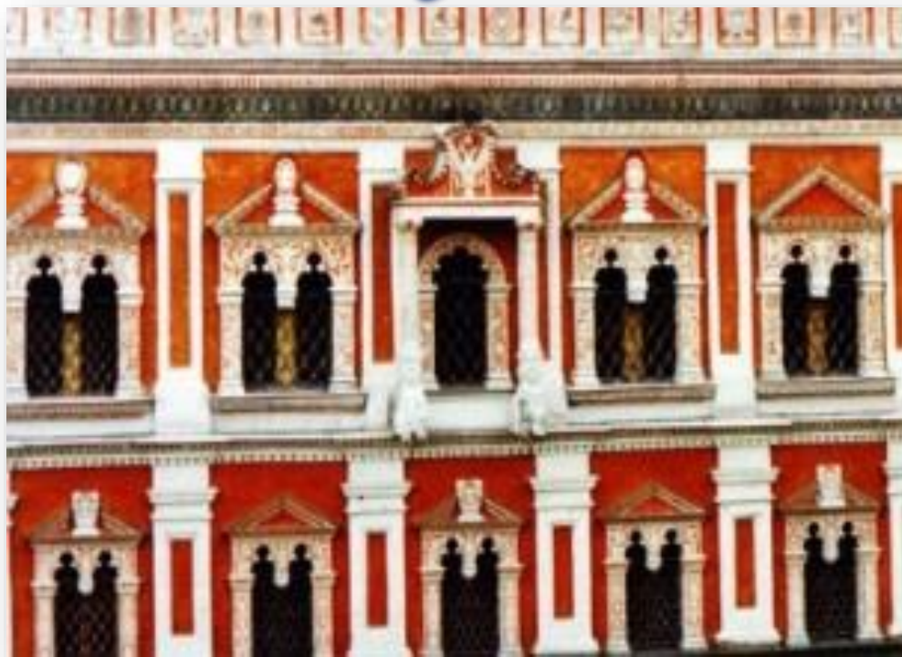
БЕЛОКАМЕННАЯ РЕЗЬБА С УЗОРАМИ НА ОКОННЫХ НАЛИЧНИКАХ
