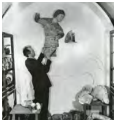
О.В. Яхонт в подклете церкви Ризоположения Московского Кремля в процессе реставрации и реконструкции белокаменной скульптурной иконы Святого Георгия (1464)
